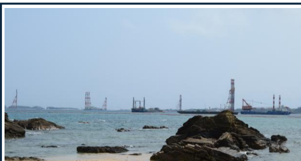
↑ 杭打ち作業が続く大浦湾（名護市） 現在のペースでも、地盤改良まで20年以上掛かる。
