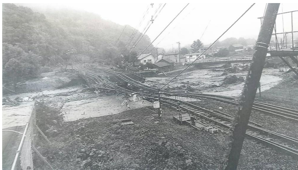
新得駅構内の橋梁が流され寸断する石勝線（札幌夕～帯広間）
